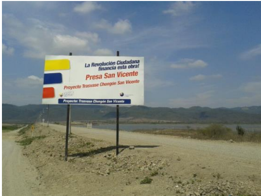
Camino de acceso al Embalse San Vicente
