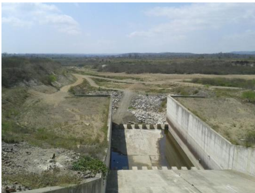
Disipador de energía del vertedero en el embalse de San Vicente
