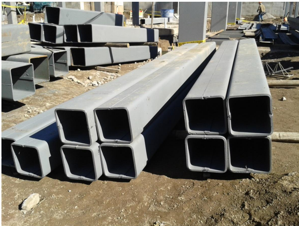
Fotografía 1: Perfiles de Acero Tipo Cajón
