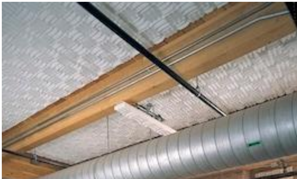
Figura 3.10. Panel cielorraso de gypsum dispuesto para el techo
