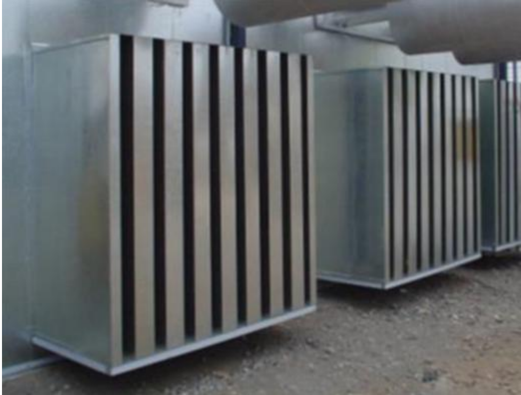
Figura 1.16. Diseño de silenciadores resistivos (Gerges y Arenas, 2004, p. 372)
