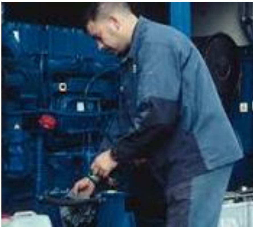
Figura 3.21. Personal en mantenimiento del generador
