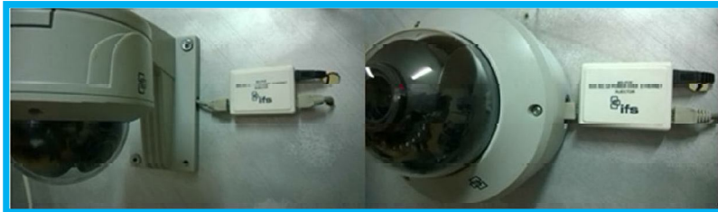
Figura 3. 4 Cámaras fijas conectadas al equipo PoE
