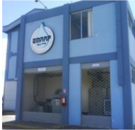
Fig. 1.4 Transformadores de 500 [kVA] y 100 [kVA] correspondientes a los servicios auxiliares
