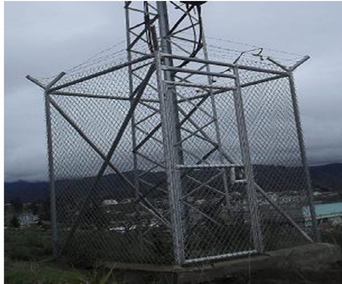
Grafico 20. Cerramiento de malla
