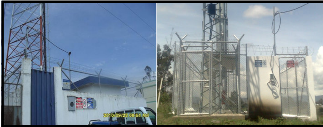
Grafico 13. Tipos de cerramientos pen estaciones celulares
