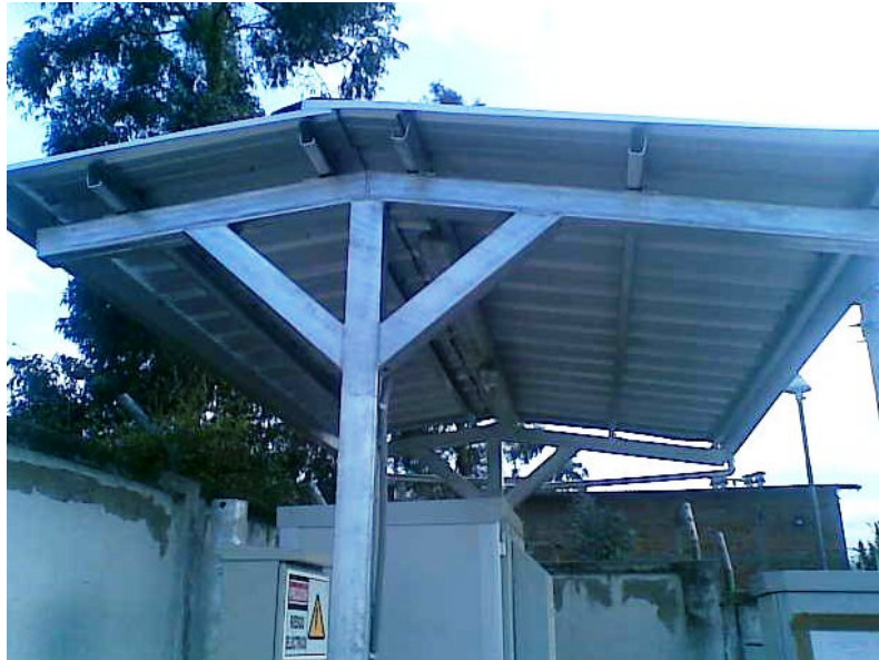
Grafico 15. Cubierta tipo para equipos
