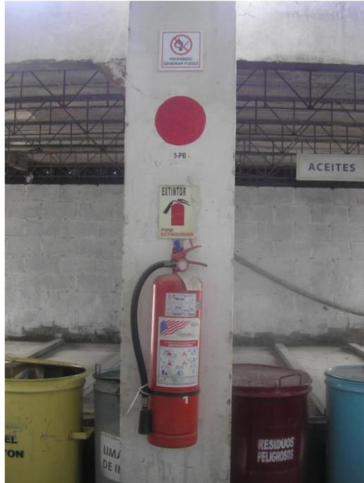
**Figura 3.14.** Señalización de extintores
