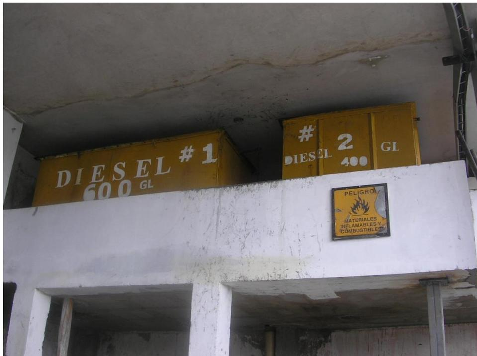
**Figura AXVI.2.** Dique de contención para tanques de almacenamiento de diésel
