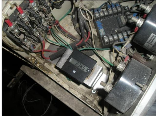
**Figura 3.1.** Horometro instalado en generador eléctrico
