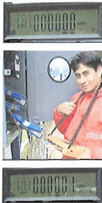
Fig. 3.17: Medidor a modo de prueba y sometido a contrastación con el analizador industrial de carga, se muestra el momento de cambio de 0 a 1 kWh.
