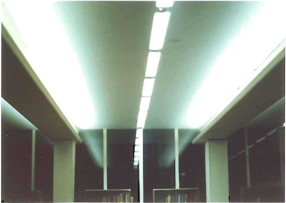
Fig. 5.2 Sector central de la sala de lectura con el nuevo alumbrado directo-indirecto.
