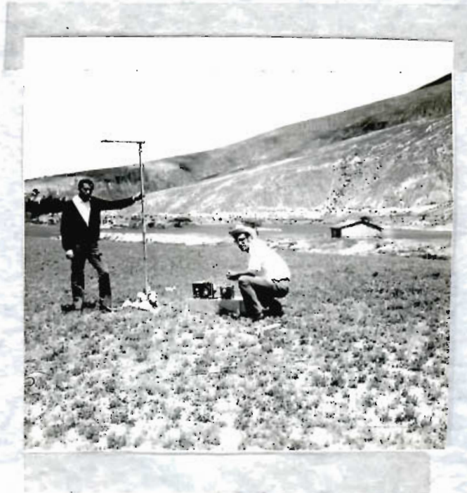
Fig. 3.11 Instalaciones necesarias en la estación transmisora.
