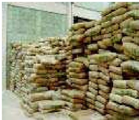
**Figura 4.4. Forma incorrecta de almacenamiento**
