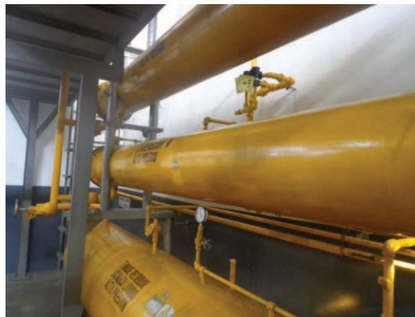
Figura 2.10 Condensador de tubo y coraza Nro. 1
