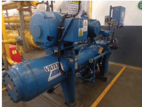
Figura 2.9 Compresor de tornillo
