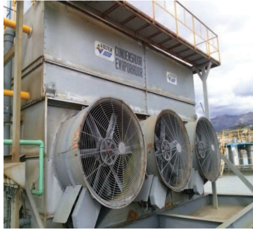
Figura 2.11 Condensador evaporativo
