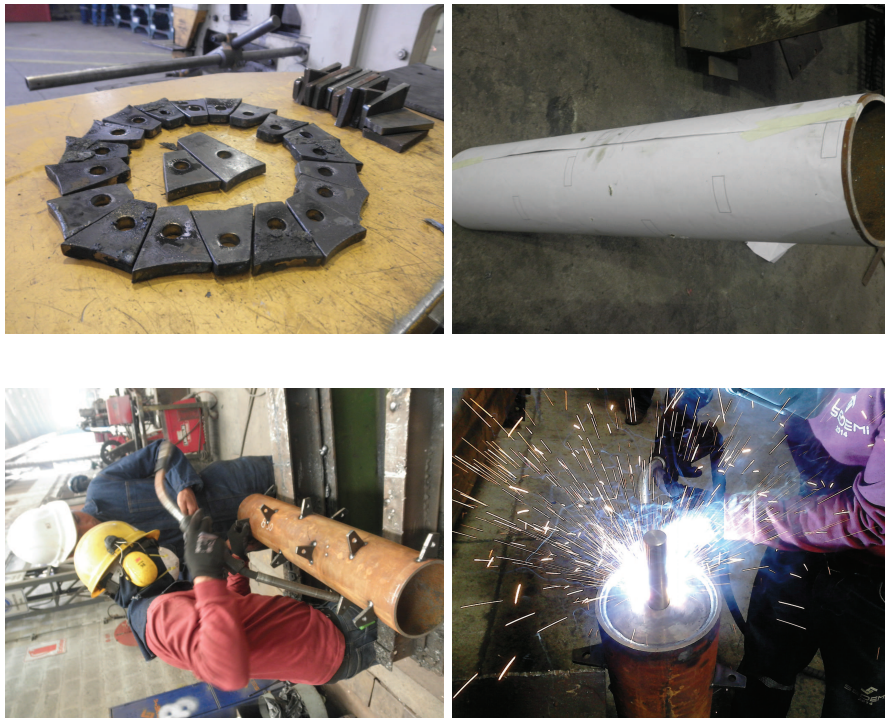
Figura F.2: Armado y Soldado del Cilindro Trillador
