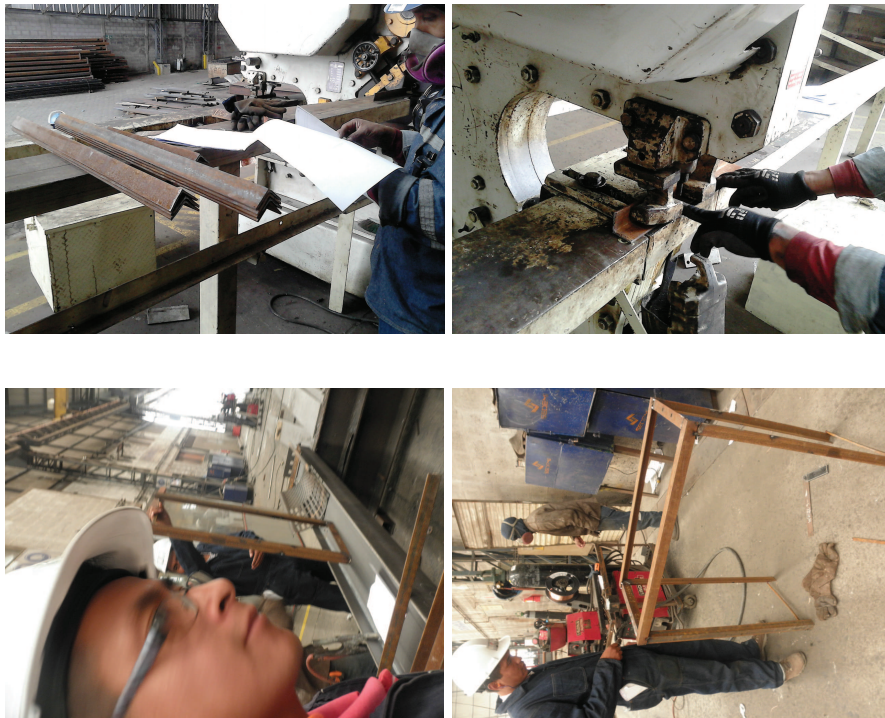
Figura F.4: Corte y Armado de la Estructura de la Máquina
