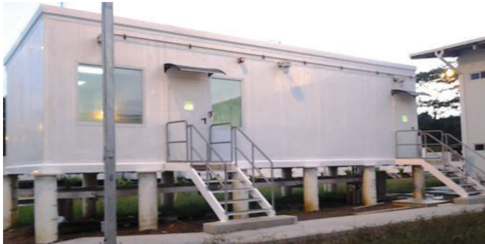
Figura 3.2 Exterior del Data Center
