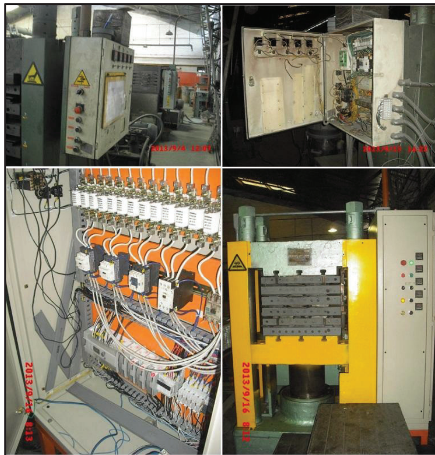
Figura 3.2. Montaje sistema eléctrico
