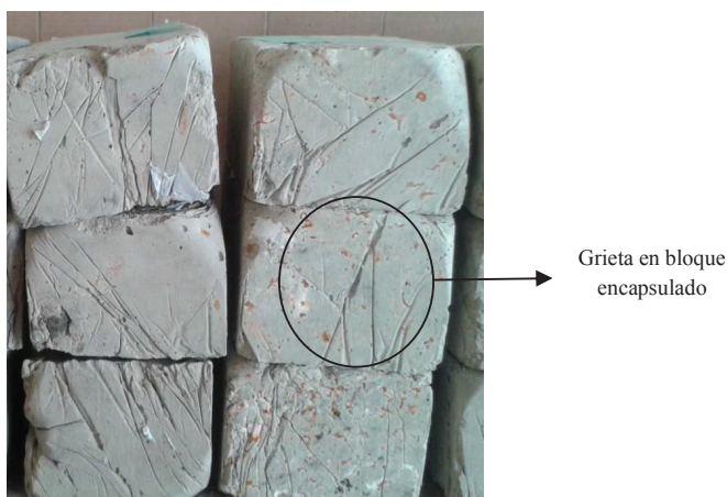
Figura 3. 20 Grietas en bloques encapsulados.
