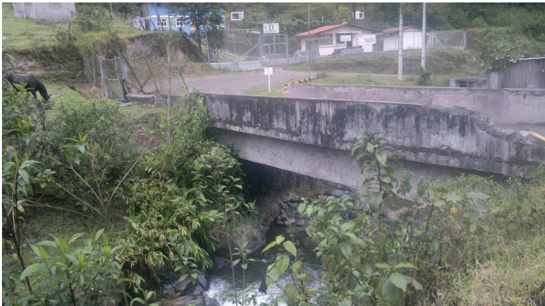
Figura 4.16 – Puente sobre el rio Saloya (Elaborado por el Autor)
