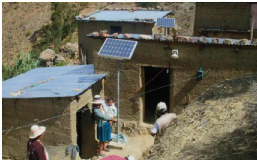
Figura 2.9 – Instalaciones con Paneles Fotovoltaicos en sectores rurales ( http://www.tvperu.gob.pe/noticias/economia/negocios/46034-gobierno-instalara-500-mil-paneles-solares-para-electrificar-zonas-rurales.html )
