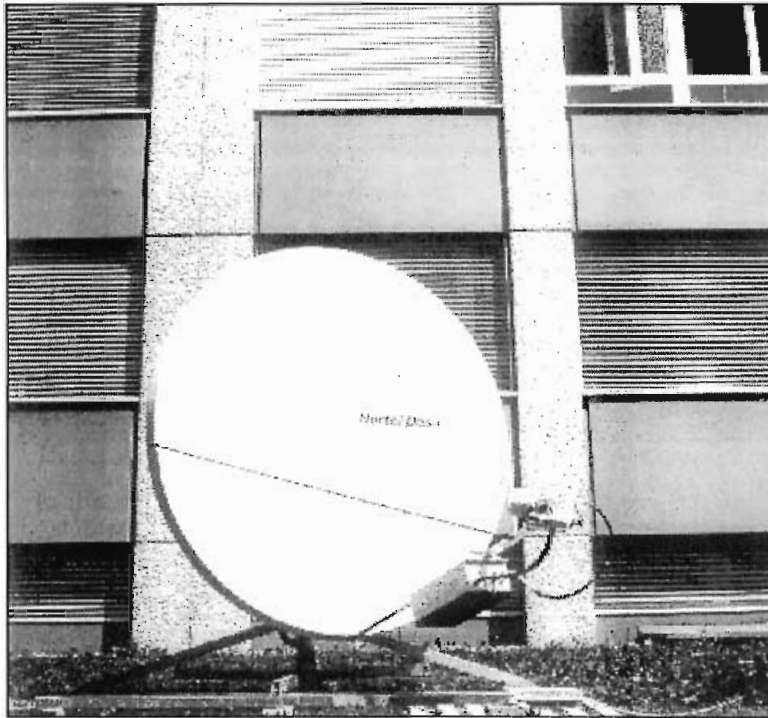
Figura 3-2-a. Unidad exterior de una estación ABCS [1]
