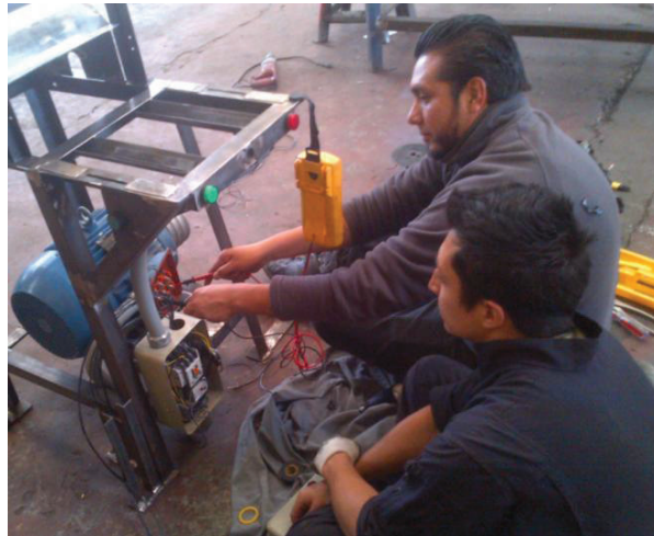
Figura N.4. Proceso de conexión del arrancador.
