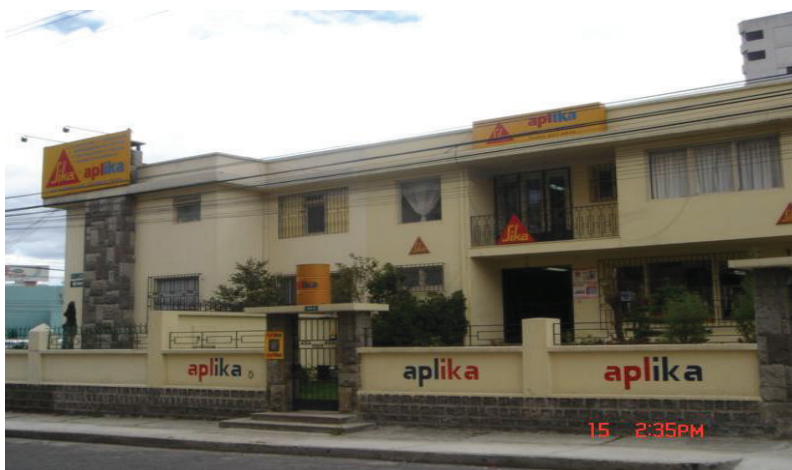
Figura 2 – Fachada local principal empresa Aplika Cía. Ltda.
