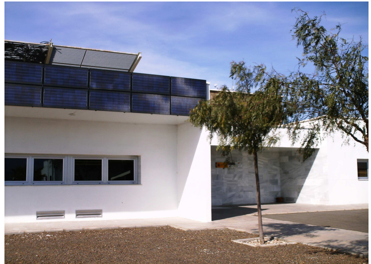
Fig. 1. Vista parcial de la fachada sur del edificio ARFRISOL en la cual se puede observar la ubicación de los paneles fotovoltaicos en el pretil.
