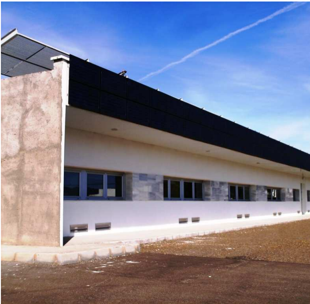
Fig. 2 Vista de general de la fachada sur del mismo edificio donde se muestran la ubicación de los paneles fotovoltaicos sobre el pretil.
