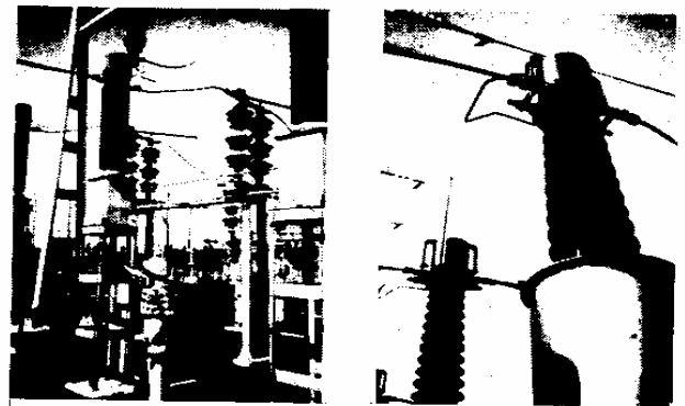
Figura 2: Centelhadores Haste-Anel Acoplados em Transformadores de Corrente de Linha de Transmissão (CESP - 138 kV).
