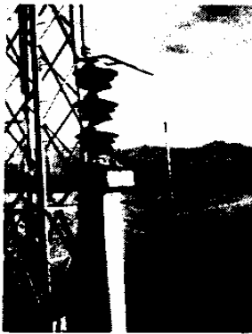
Figura 3: Centelhador Hasté-Anel Acoplado em Isolador Pedestal na Entrada de uma Linha de 138 kV (FURNAS).
