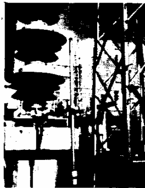
Figura 3: Centelhador Hasté-Anel Acoplado em Isolador Pedestal na Entrada de uma Linha de 138 kV (FURNAS).
