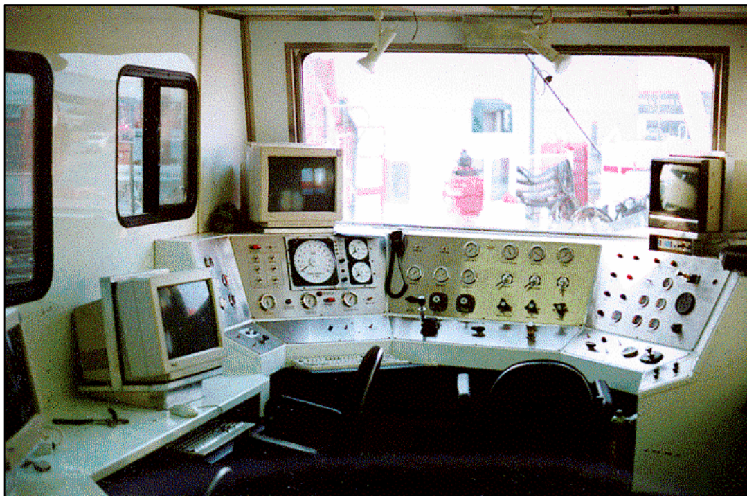
FIG. 3.4: CABINA DE CONTROL
