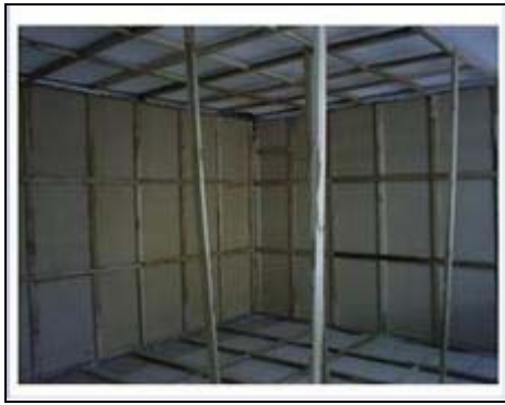
Figura 15. Estructura de madera
