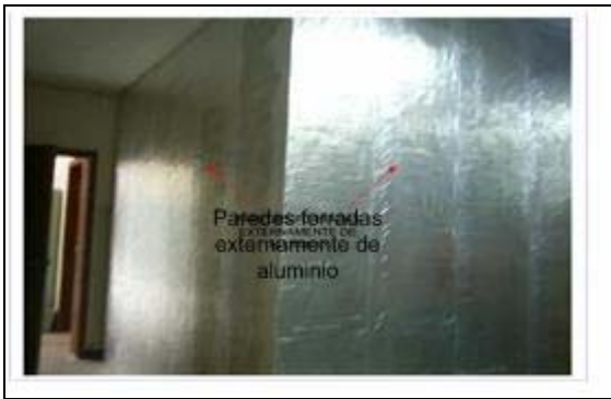
Figura 16. Recubrimiento externo de aluminio
