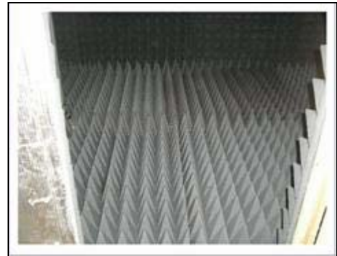
Figura 20. Interior de la Cámara terminada
